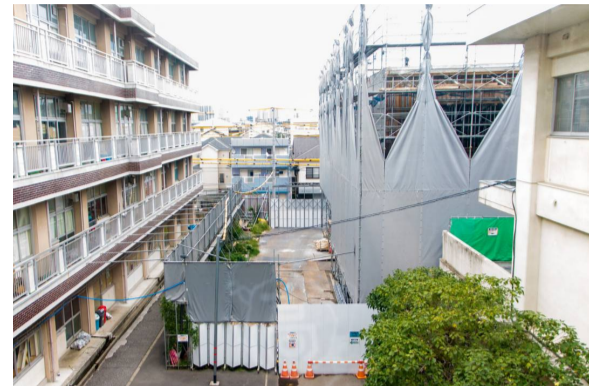
旧体育館跡地では、新校舎を建設中(3F渡り廊下より)
